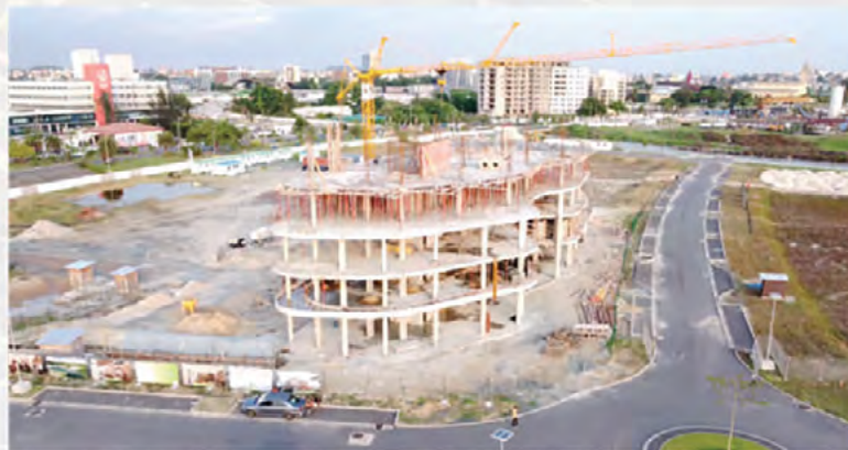
Aperçu d'un bâtiment en construction
