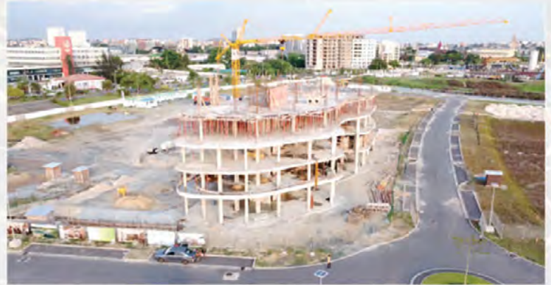
Aperçu d'un bâtiment en construction
